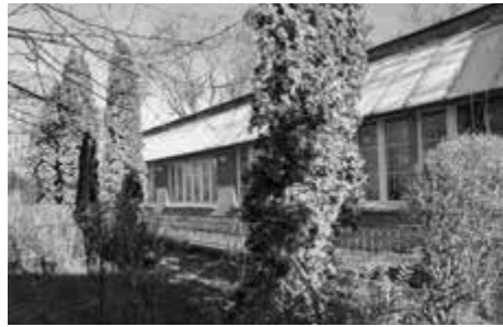
Die Tuberkulosestation Czernys im Park der Klinik, heutiger Zustand. Die Verglasung ist durch Zinkblech ersetzt. Aufnahme des Verfassers, März 2025
