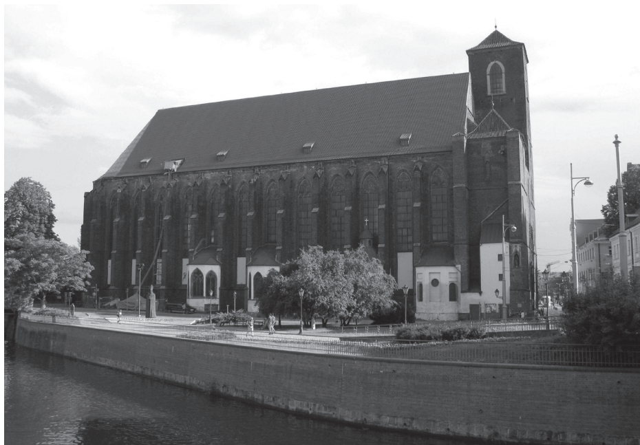
Abb. 1 Die Nordfassade der Kirche Maria auf dem Sande
