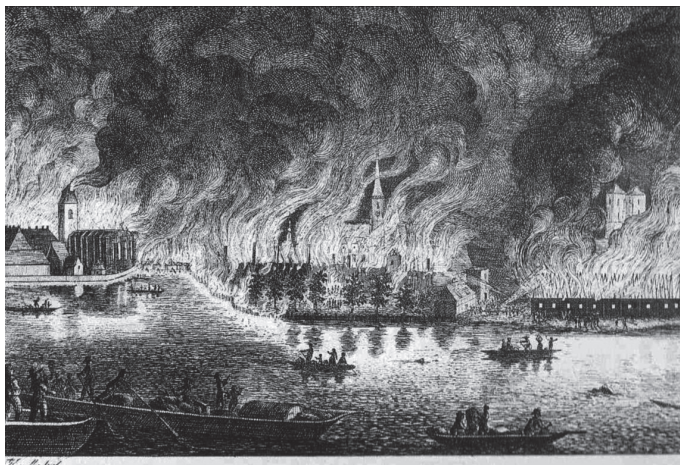
Abb. 8 Der Großbrand auf Sand- und Dominsel am 25./26. Mai 1791
