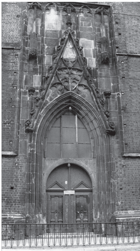
Abb. 2 Das Portal vor der Restaurierung im Dezember 2013
